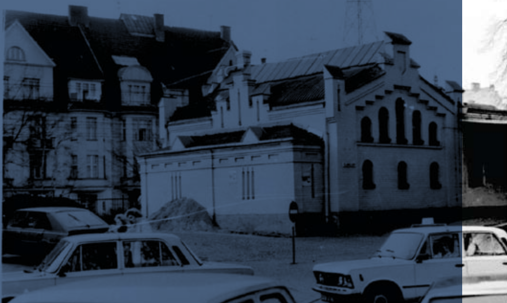
Toaleta na dworcu w Sopocie, fot. Ryszard Kisiel
